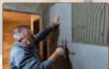
■ Pose de carrelage
